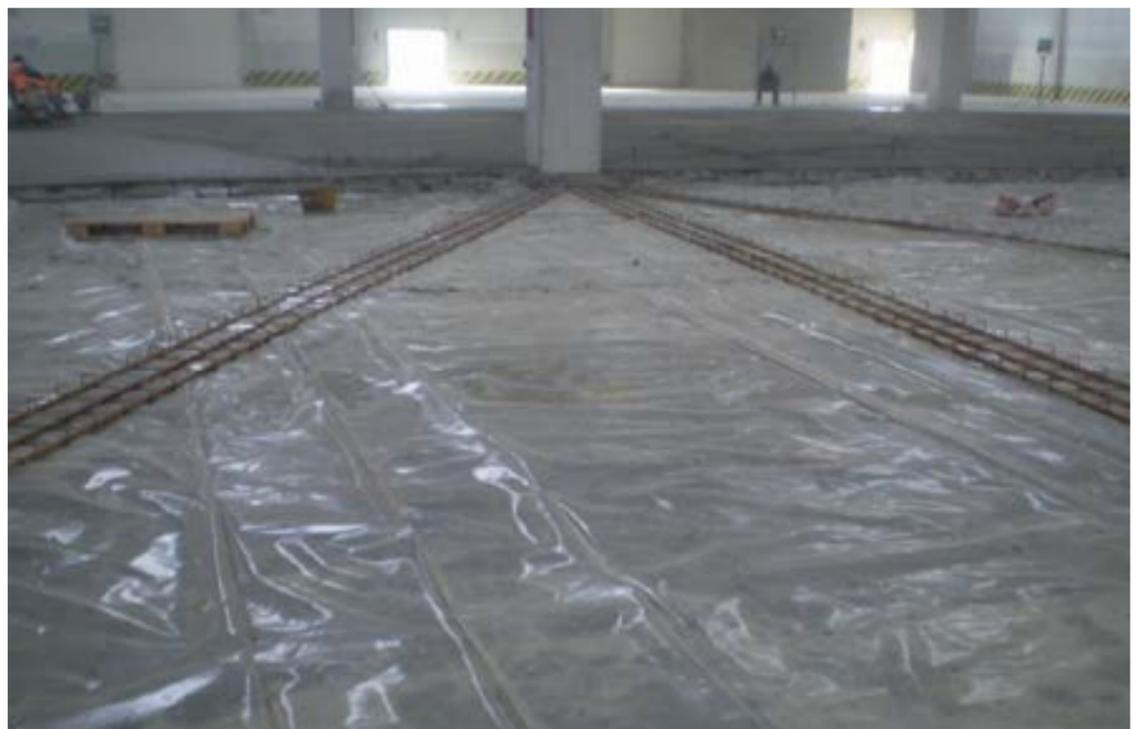
FIGURA 1 - Dettaglio del sistema isteretico orizzontale sulle piastre: bielle di collegamento
