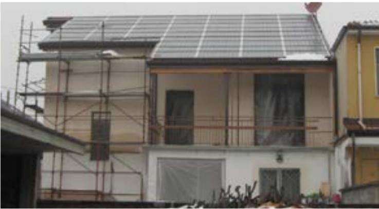
**Nuova edificazione di un piano mansarda aggiuntivo: Impianto integrato Solrif, due tipi di modulo 15 kW-lattinerie assenti. Progetto edile: Progetto Habitat di geom. Giuliano Bennati. Progetto integrato Fotovoltaico: ing. Alessio De Angelis Adea S.r.l.**
