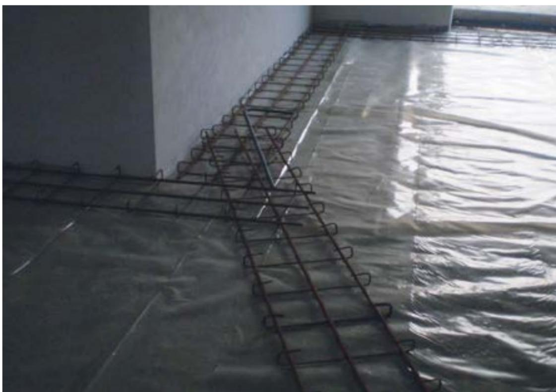
FIGURA 2 - Dettaglio del sistema isteretico orizzontale sulle piastre: biella su trave perimetrale
